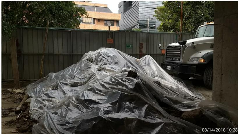
*Ilustración 3. Protección de acopio de materiales Fuente: SUMAC*
